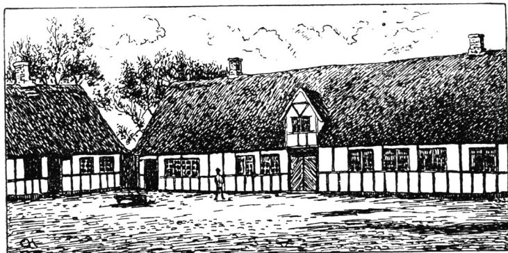
Bormholm før Ombygningen 1915. (Efter Fotografi).
