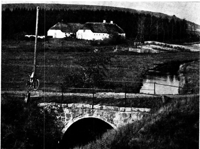
Skade bro og Skade aa set mod Ulvbjerg. 1913.
